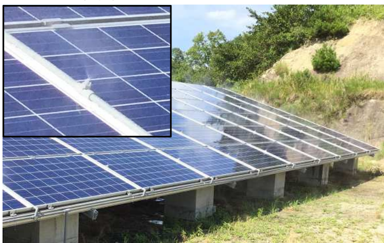
設置事例(香川県さぬき市)※太陽光パネル全体がウォールミストにより均一に冷却され、鏡面状態(空・雲・山が映りこんでいる。)になっています。
